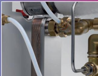
Die standardmäßige Kühlung über einen Edelstahl-Plattenwärmetauscher mit Magnetventil gewährleistet höchste Kühlleistung auch bei geringen Temperaturdifferenzen und senkt den Energieverbrauch.
